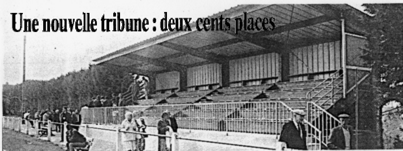
Vue d'ensemble des nouvelles tribunes
